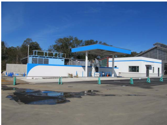
水素ステーション全景（2号機）
